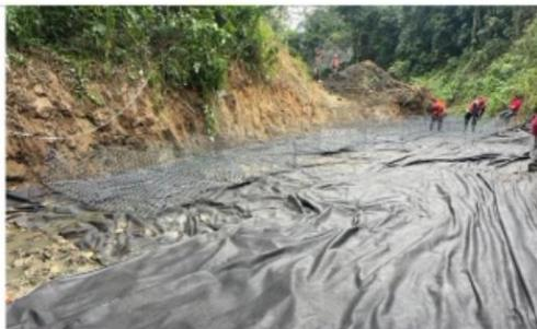
COLOCACION DE GEOTEXTIL (E 0 + 740)
