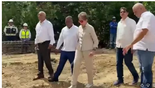
La senadora Ginnette Altagracia Bournigal Socías de Jiménez muestra construcción del puente Camú.
