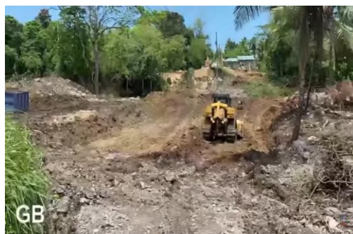
La senadora Ginnette Altagracia Bournigal Socías de Jiménez muestra construcción del puente Camú.
